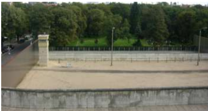
写真：壁の様子
