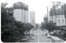
建設中の都庁舎 平成元年(1989)
